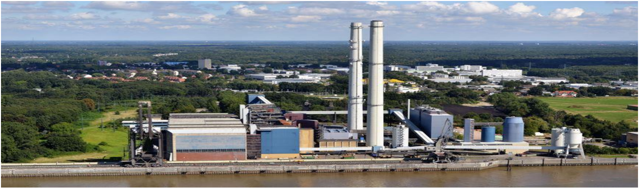
Steinkohle-Heizkraftwerk Wedel (Bild: Wärme Hamburg GmbH)
